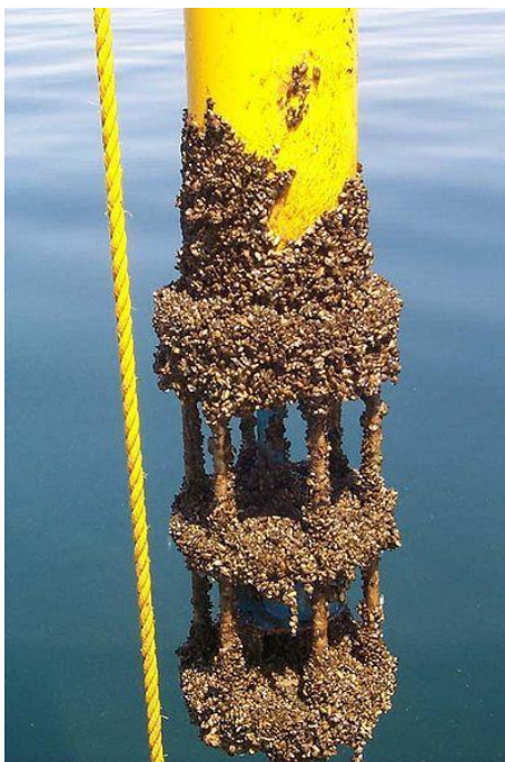
Figura 1- Estrutura onde ocorreu bioincrustação
