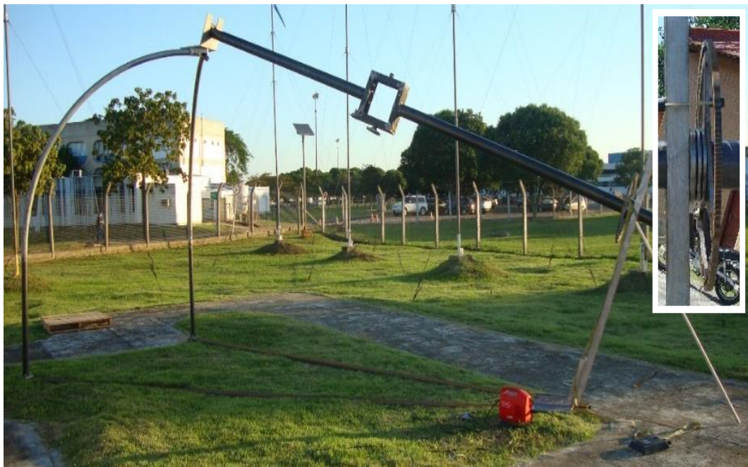
Figura 28 - Estrutura de sustentação do Disco Solar
