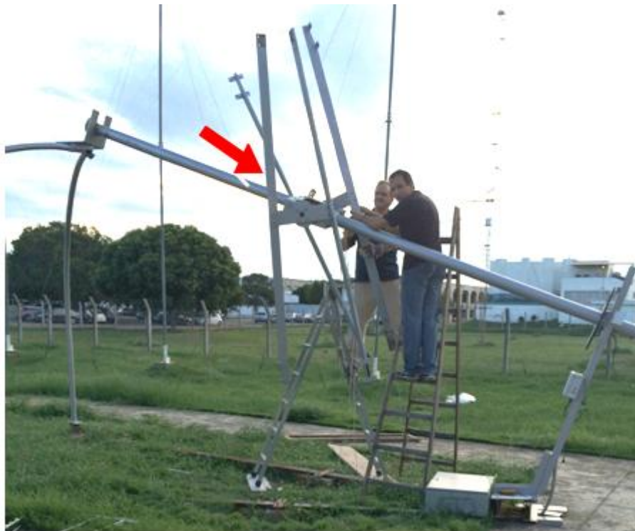
Figura 25: Montagem da estrutura de sustentação do disco solar.
