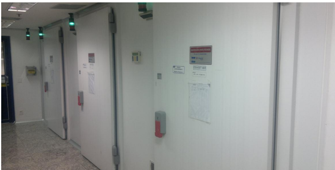
Figura 3 – Vista externa das câmaras de estabilidade.
