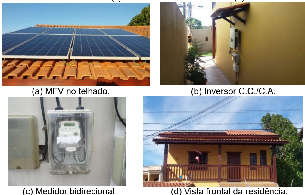
Figura 36 – Vista dos MFV instalados sobre o telhado (a), inversor CC/CA (b), medidor bidirecional (c) e vista frontal da residência (d).
