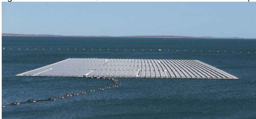
Figura 38 – Vista da primeira etapa da usina fotovoltaica flutuante, instalada na lâmina d'água do reservatório da UHE de Sobradinho no estado da Bahia (Ba).
