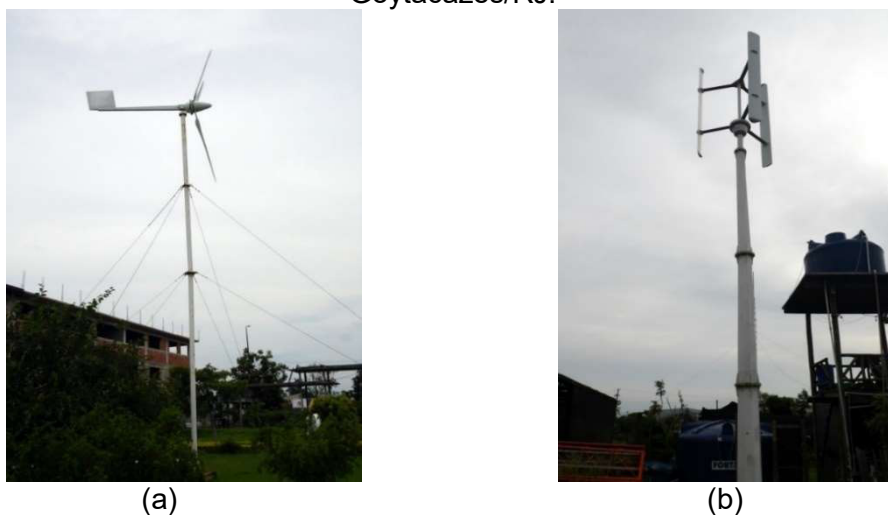
Figura 13 – (a) Turbinas eólicas de eixo horizontal com potência nominal de 6 kW instalada no Instituto Federal Fluminense campus Campos-Guarus e (b) Turbinas eólicas de eixo vertical com potência nominal de 1,5 kW instalada no Polo de Inovação Campos dos Goytacazes/RJ.
